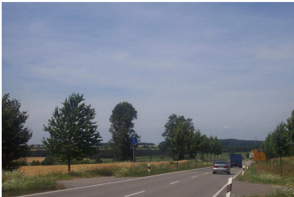
Abb. 5: Blick von Süden, Westallee
