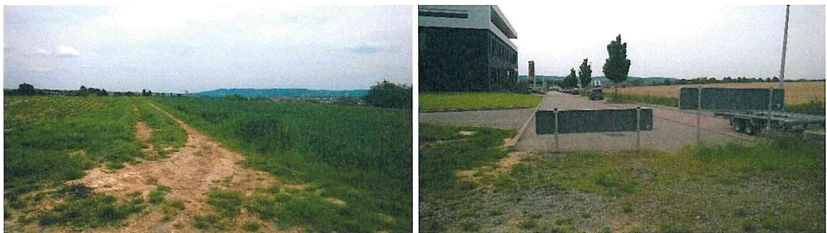
Bild 3 und 4: Anschluss an bestehende Rudolf-Diesel-Straße, Blickrichtung nach Osten und Westen
